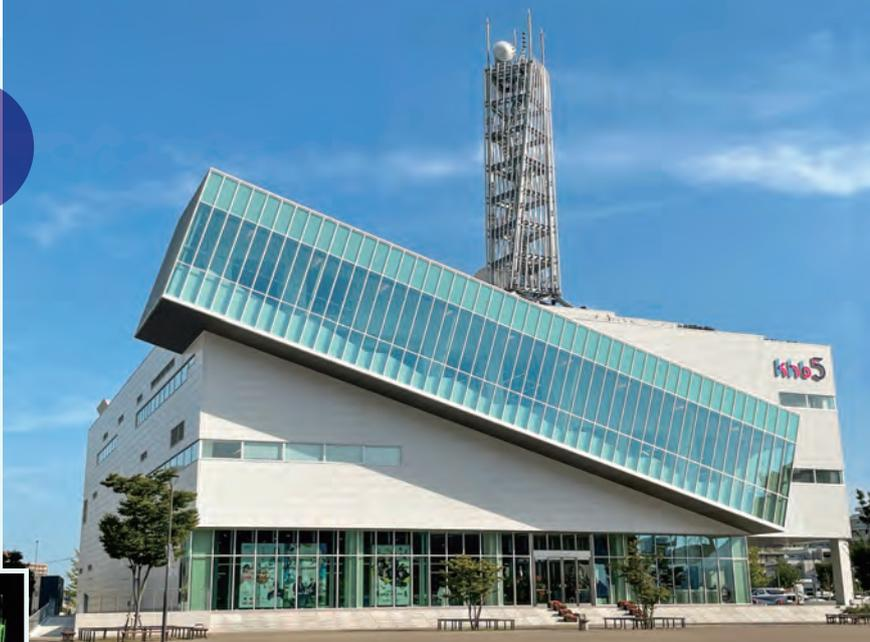
▲鉄塔と斜めに張り出したガラスの階段。災害時に放送を継続できるよう、耐震安全性を最高レベルに設定。電源供給は、本線と予備線の2系統受電にして停電リスクを軽減し、さらに非常用発電機は2台設置。地下埋設タンクには30000ℓの軽油を燃料として備蓄し、7日間の継続発電を可能にしている。また、近隣河川氾濫の場合を想定し、1階床を1m高床化に整備している。
